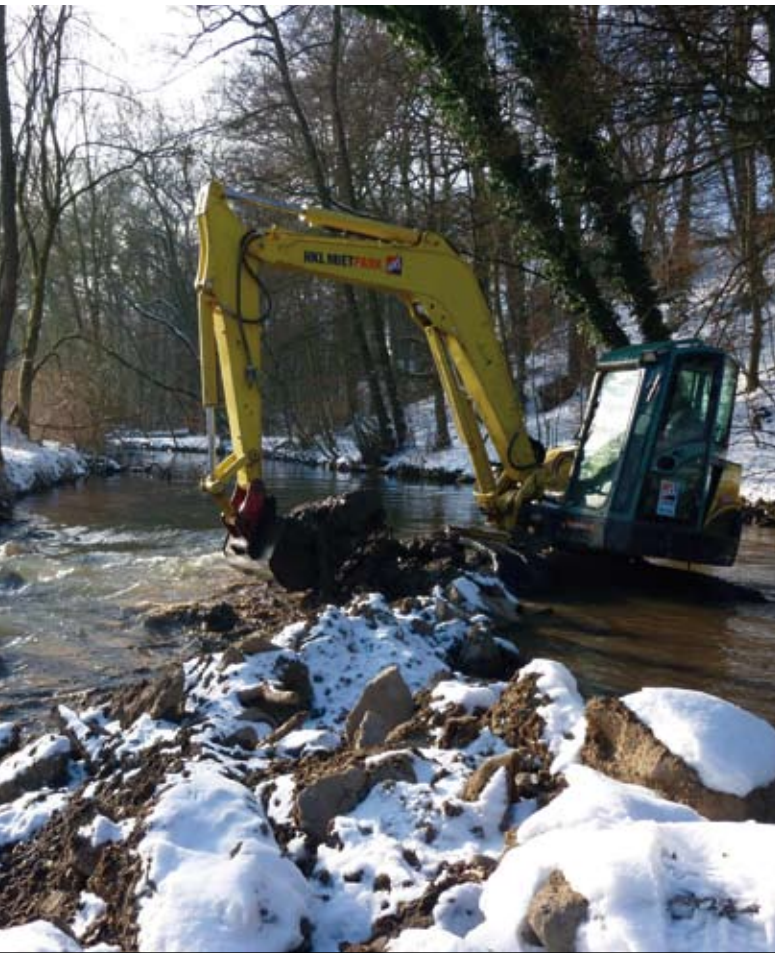
Der Durchstich im Februar 2010: die Dhünn fließt in das verlegte Bachbett (Quelle: Wupperverband)
